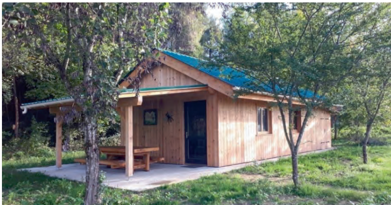
La cabane entièrement terminée.
